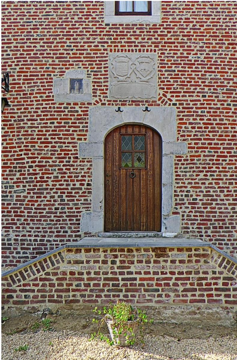
Les baies à gauche et à droite de la porte sont à croisée. Dans la partie gauche du bâtiment qui a été moins rehaussée que le reste, la baie présente un meneau (séparation verticale en pierre). Les parties basses des fenêtres à croisée et la fenêtre à meneau sont équipées de volets battants. Dans ce coin de la cour trône un puits surmonté d'une belle ferronnerie.
