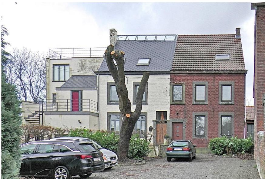
La maison du numéro 30 possède un encadrement de porte en pierre calcaire qui comprend une traverse d'imposte ondulante, alors que tous les autres encadrements sont rectangulaires. L'encadrement de l'imposte est en briques. Il est probable qu'à l'origine, l'encadrement de la porte devait être semblable à celui du numéro 29.
