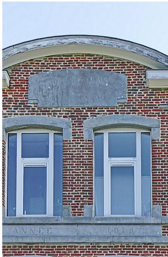
teau délardé, posé sur console. Les appuis de fenêtre en pierre calcaire sont également posés sur deux consoles. Le toit est en ardoises, sur corniches en bois. Une stèle commémorative de la guerre 1914-1918 a été posée sur la façade à droite de la porte d'entrée de la maison communale. Elle porte l'inscription suivante :
